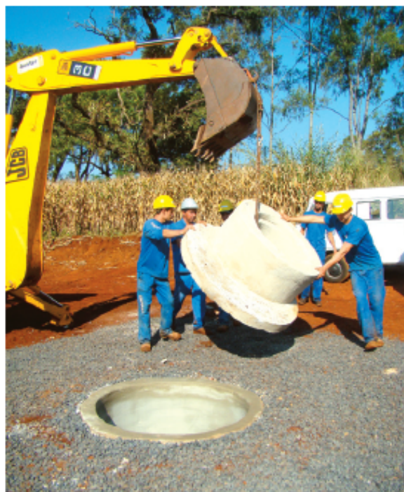
Obra de ampliação da rede
