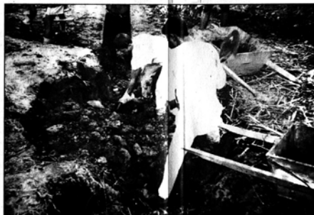
Remoção do solo contaminado para a Estação de Biorremediação
