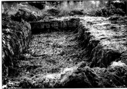
Estação de biorremediação, onde o solo contaminado foi depositado para adição do Biorremediador "Oil Gator".
